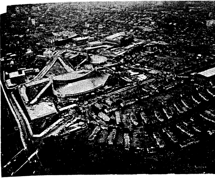
空から見た全景
