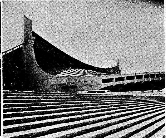
斬新な設計による釣橋式屋根
