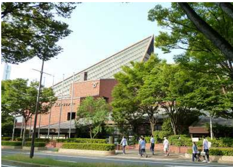
神戸市立ホートアイランドスポーツセンタープール
